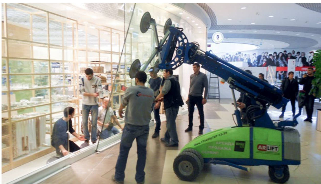
Монтаж внутри помещений
