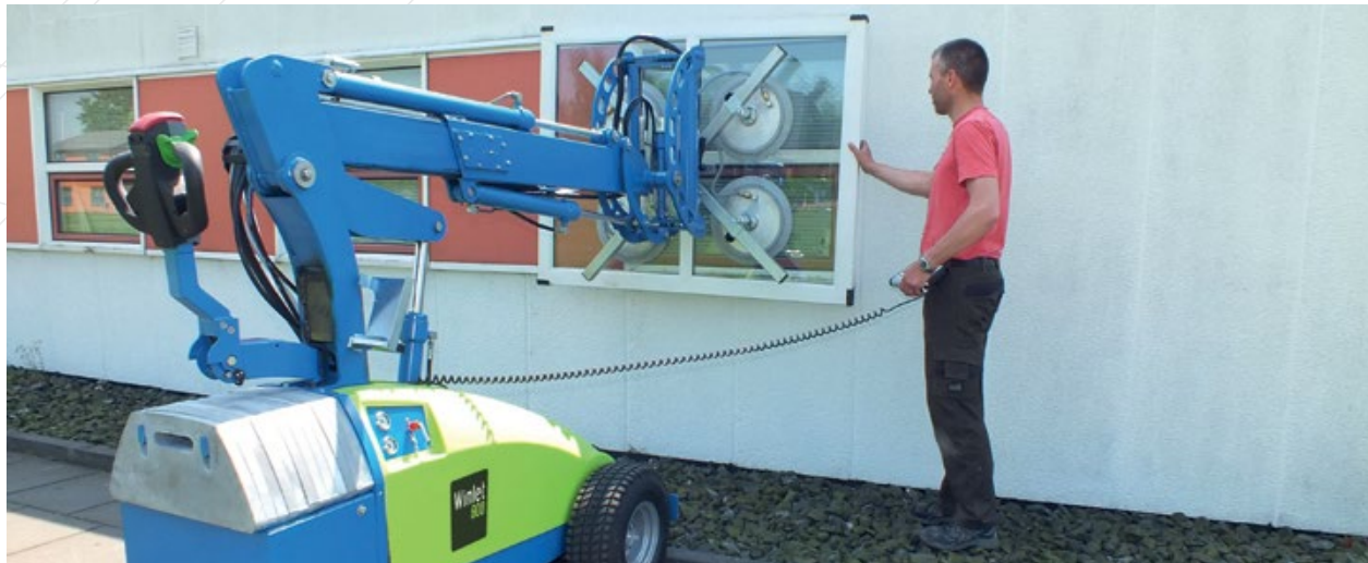
Монтаж с улицы
