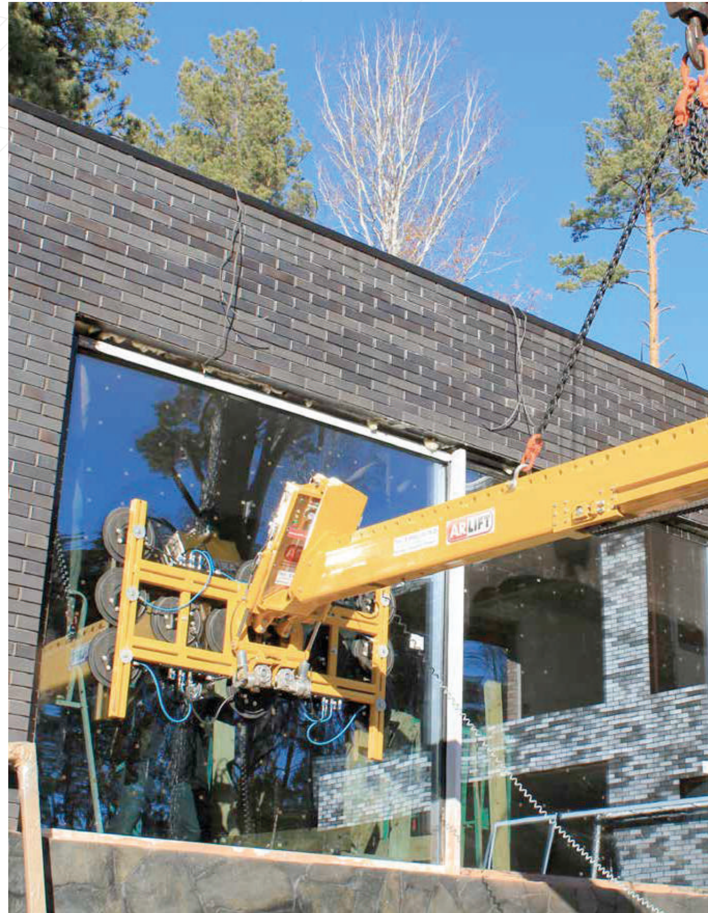
МОНТАЖ КРУПНОГАБАРИТНОГО СТЕКЛА
